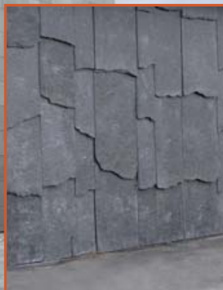
Bruddheller i Ottaskifer til fasade.
